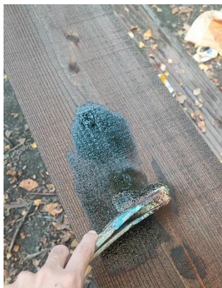
防腐剤の塗布の様子
