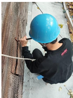
古い板を取り外す様子
